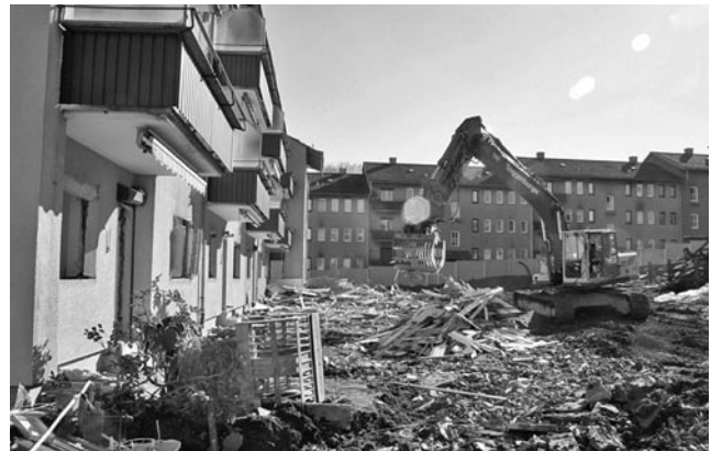
Abbruchobjekt/demolition site, Wehntalerstrasse, Affoltern
